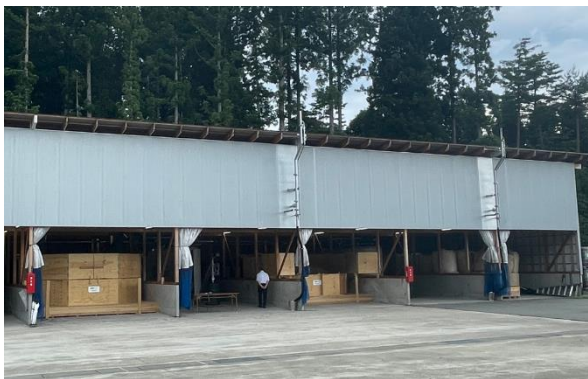
小型熱電併給バイオマス発電機及びチップヤード
